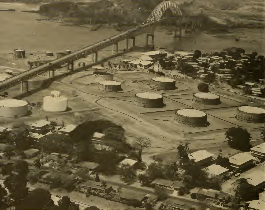
Vista aérea de Balboa donde se aprecia parte del patio de tanques de La Boca donde hay tanques de propiedad comercial y tanques arrendados y de propiedad del Canal de Panamá.
